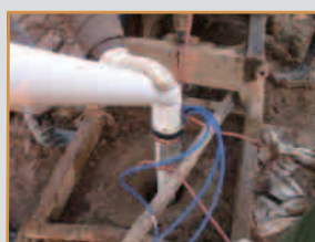
◆ 路基、地基处 理现场施工图 ◆
