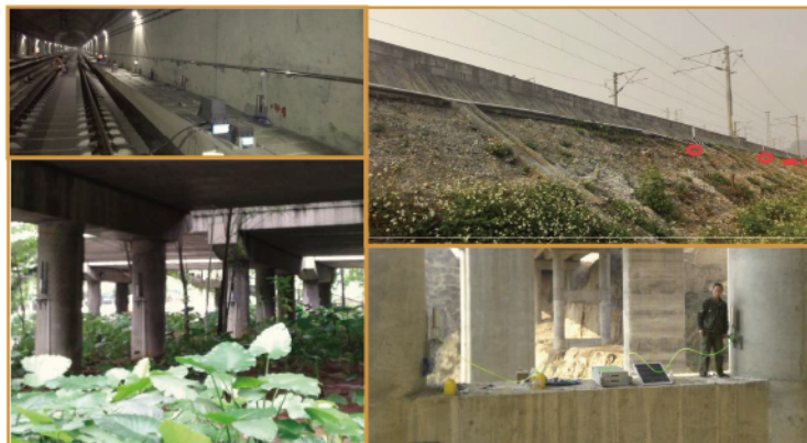
◆ 静力水准仪安装现场 ◆
