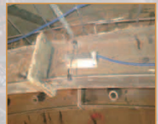
隧道工字钢钢梁支撑应变监测
