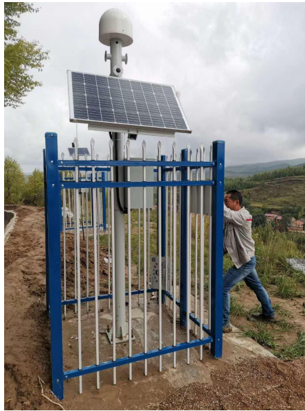
GNSS 监测站-安装现场实物图
